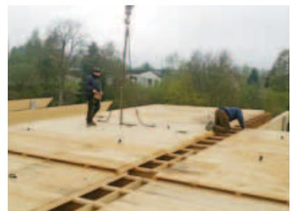
Zimmermannsmäßige Verbindung der Dachelemente über Montageöffnungen
