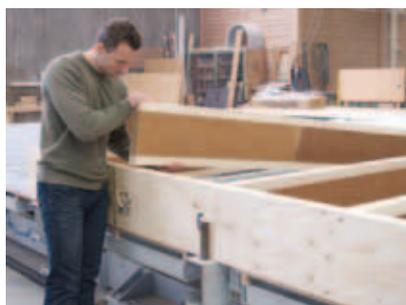
Vorfertigung von Wand- und Dachelementen mit STEICOjoist und STEICOWall. STEICO LVL bildet Schwelle und Rähm sowie die seitlichen Elementrahmen.
