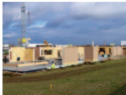
Stellen der vorgefertigten Wand- und Deckenelemente. Aufgrund des hohen Vorfertigungsgrades musste die Bautätigkeit auch während der Wintermonate nicht unterbrochen werden. So konnte das Gebäude in nur 10 Monaten Bauzeit fertiggestellt werden.
