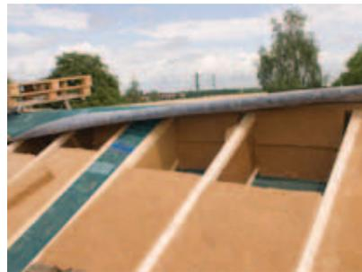
Blick in die Dämmebene der Dachkonstruktion. Vorgeämmte STEICOjoist Stegräger mit STEICOflex Dämm-Matten.
