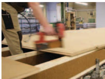
Den oberen Elementabschluss bildet eine STEICOuniversal Unterdeckplatte (Dachelemente) oder eine STEICOprotect Putzträgerplatte (Wandelemente).
