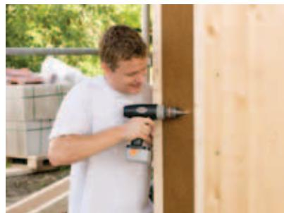
Befestigung von STEICOWall Stegrägern mittels Holzschrauben durch den hinteren Gurt.
