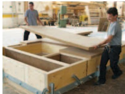
Aussenseitige Beplankung mit STEICO*protect* Putzträgerplatten. Zur Verbesserung der Freibewitterbarkeit wurde auch der Grundputz schon bei der Vorfertigung aufgetragen.
