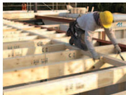
Deckenkonstruktionen für erhöhte Belastungen wurden bauseits aus STEICO LVL gefertigt.
