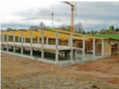
Haupttragwerk: Gabelgelagerte Brettschichtholzträger auf Stahlbetonstützen
