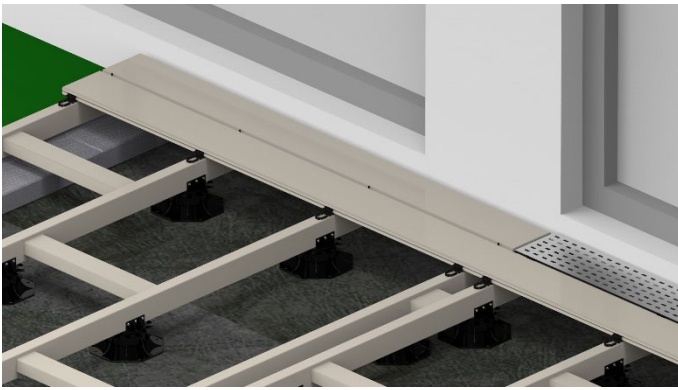
Bild 27. Wenn die erste Terrassendiele und das Drainageprofil so fixiert und eingebaut wurden, kann die 2. Dielenreihe auf die RASK-Clips geschoben werden. Schieben Sie dann die nächsten RASK-Clips unter die 2. Diele und drehen die Holzschrauben 4,2 x 50 mm (T 15) nur soweit ein, dass der RASK-Clip nicht mehr verrutschen kann.
