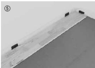
⑤ In der rechten Raumecke beginnend, werden die Elemente mit der Federseite zur Wand verlegt und mit Abstandskeilen oder Abstandhaltern fixiert (Dehnungsabstand zur Wand 10 – 15 mm).
