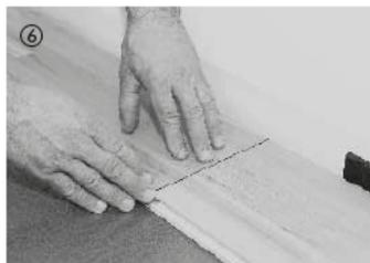
⑥ Die weiteren Elemente der ersten Reihe sind an den Kopfenden von oben in die vorherige Diele einzuklicken. Durch kurzen Druck auf den Querstoß rastet das Element im angrenzenden Element ein. Hierbei ist auf eine exakte Flucht der Elemente zu achten. Das letzte Element der ersten Reihe wird unter Berücksichtigung des Dehnungsabstandes von 10 – 15 mm zur Wand zugeschnitten und eingefügt.
