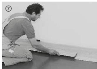
⑦ Mit dem Reststück der ersten Reihe wird in der nächsten Reihe wieder begonnen (stirnseitiger Versatz von mindestens 50 cm). Dadurch wird der Verschnitt erheblich reduziert. Die weitere Verlegung erfolgt elementweise. Dazu werden die Elemente zuerst längsseitig mit leichtem Druck in die Verbindung eingedreht.
