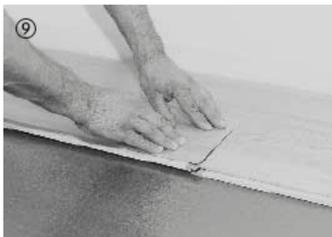
⑨ Anschließend wird das Element stirnseitig abgesenkt. Beachten Sie hierbei, dass das Element stirnseitig bündig an das zuvor verlegte Element anstößt. Durch kurzen Druck auf den Querstoß rastet das Element ein.
