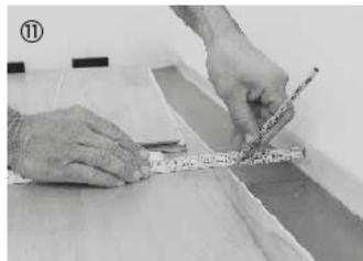
⑪ Die Elemente der letzten Reihe werden an der Längsseite unter Berücksichtigung eines Dehnungsabstandes von 10–15 mm zugeschnitten und eingepasst.
