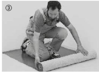
③ Zur Trittschalldämmung und zum Ausgleich kleiner Unebenheiten wird eine 2 mm dicke Komfort-Dämmunterlage bündig ausgerollt. Geeignete Dämmunterlagen finden Sie in unserem Zubehörangebot. Bitumenpappe eignet sich nicht zur Trittschalldämmung. **Parkettboden mit aufkaschierter Dämmunterlage ist für eine vollflächige Verklebung nicht geeignet.**
