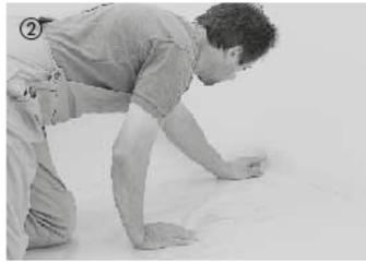
② Grundsätzlich ist bei Estrichen und bei Verlegung auf Fußbodenheizung eine 0,2 mm starke PE-Folie auszulegen. Diese soll im Stoßbereich 30 cm überlappen. Anschließend die Folie im Wandbereich hochziehen und nach der Sockelleistenmontage an der Oberkante abtrennen.
