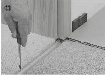
13 Zur Einhaltung des Dehnungsabstandes muss bei Türübergängen stets ein geeignetes Profilsystem eingesetzt werden. Dies gilt auch, wenn im angrenzenden Raum der gleiche Boden verlegt werden soll. In diesem Fall ist für die Einhaltung der Dehnungsfuge ein Übergangsprofil einzusetzen. In der Schiene ist ein Dehnungsabstand von ca. 5 mm einzuhalten. Grundsätzlich müssen Holztürstöcke in Parkettelementdicke mit einer Feinsäge abgeschnitten werden, damit das Parkett eine Dehnungsmöglichkeit hat.
