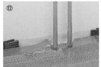
⑫ Für aus dem Boden herausragende Heizungsrohre werden in die Elemente Öffnungen (Größe abhängig vom jeweiligen Heizungsrohr und unter Berücksichtigung des erforderlichen Dehnungsabstandes) gebohrt und gesägt.
