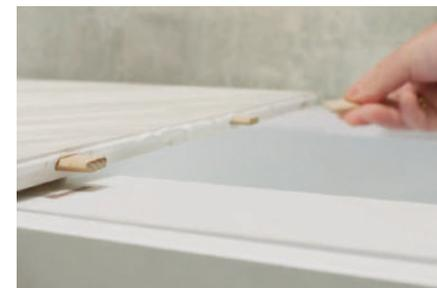
Nun müssen Sie die Tischplatten ordnungsgemäß zusammenfügen, sie perfekt in einer Ebene ausrichten und die Befestigungsschrauben anziehen. Sollte zu viel ColorJoint auf die Fuge aufgetragen worden sein, verwenden Sie die andere Seite des Applikators, um die Dichtmasse abzurakeln. Entfernen Sie mit dem Daumen überschüssiges Dichtmittel an der Vorderkante (90-Grad-Winkel).
