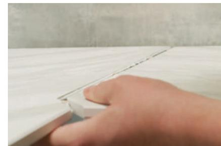
Entfernen Sie die restliche Dichtmasse von der Tischplattenoberfläche. Wischen Sie dazu mit einem Tuch vorsichtig über die entstandene Fuge auf der Tischplatte. VORSICHT! Wischen Sie nicht an der Dichtung entlang, da dadurch die Dichtmasse aus der Fuge entfernt werden kann. Alle Tätigkeiten bei der Verwendung von ColorJoint müssen innerhalb von 15 Minuten nach dem Öffnen der Tube abgeschlossen sein.
