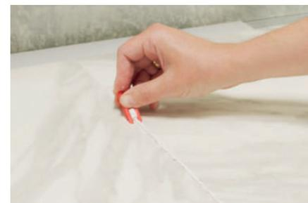
Zur Reinigung der Tischplattenoberfläche kann der Reiniger "Schichtstoff-Arbeitsplatten. Reinigung und Pflege" verwendet werden. Eine korrekt aufgetragene ColorJoint-Versiegelung gewährleistet eine 100%ige Wasserdichtigkeit und Haltbarkeit der Tischplatte.
