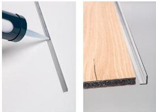
In die Profillinenseite von RESOPAL SpaStyling® Abschlussprofil (L-Profil) RESOPAL SpaStyling® Verbindungsklebstoff angeben. Die Angabe von dem Klebstoff muss genau dosiert werden. Anschließend wird das Profile an den Längsseiten von RESOPAL SpaStyling® Board angedrückt. Die Verbindung zwischen Profil und RESOPAL SpaStyling® Board muss wasserdicht ausgeführt werden. RESOPAL SpaStyling® Verbindungsklebstoff, der aus den Profilen ausgequollen ist, muss sofort von der Oberfläche entfernt werden.
