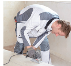
Für den Wandanschluss ist der Stufenfalz abzutrennen
