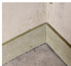
Randdämmstreifen dicht bis in die Wandecke anschließen
