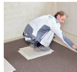
Verlegung der Estrichelemente auf Rigidur Ausgleichsschüttung mit Hilfe von Laufinseln
