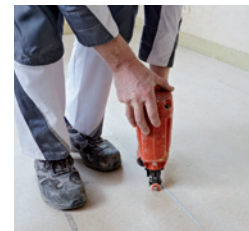
Fixierung mit Spreizklammern
