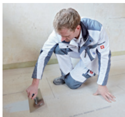
Überspachtelung der Befestigungspunkte und eventueller Fehlstellen
