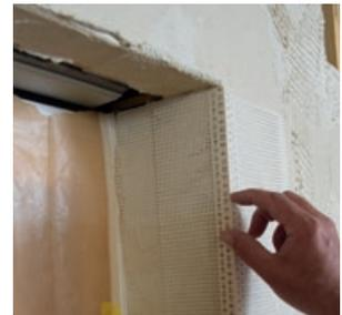
Der STEICOsecure Base Armierungsmörtel wird an Außen-ecken von Wänden und Laibungen aufgetragen und anschließend der Gewebeeckwinkel eingespachtelt.
