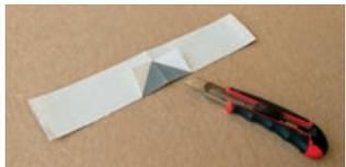
2. Ecken nach oben falten, so dass ein gleichschenkliges Dreieck entsteht
