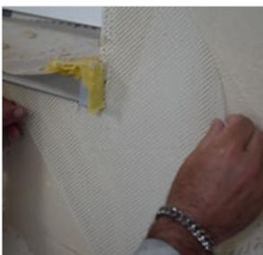
Die Diagonalarmierung wird in Öffnungsbereichen direkt nach der Montage der Gewebe-Eckwinkel (nass in nass) ebenfalls mit Armierungsmasse eingespachtelt. Die Geometrie des Armierungsstreifens ist so ausgerichtet, dass er pfeilförmig diagonal in allen Ecken angebracht werden kann.
