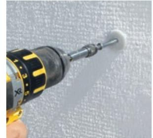
Leichte Lasten wie Außenlampen oder Briefkästen können mit Dämmstoffdübeln wie der STEICO Montagespirale in der STEICO*protect dry* Platte befestigt werden. Das Loch für die Montagespirale muss mit einem Holzbohrer mit 8 mm Durchmesser vorgebohrt werden.
