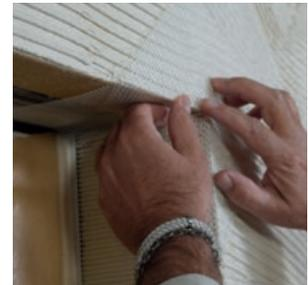
Im Bereich des Fenstersturzes bieten die Sturzeckwinkel eine Möglichkeit, um auch in der Innenecke der Laibung eine ausreichende Armierung sicherzustellen.
