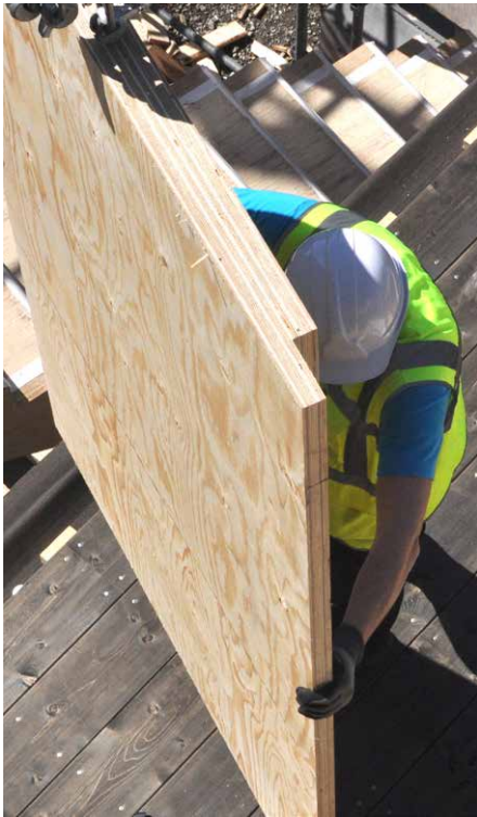
Kerto LVL Q-panel Stufenfalzplatten können sowohl für Bauteile von Einfamilienhäusern verwendet werden, als auch für Bauteile im Mehrgeschossigen Holzbau.
