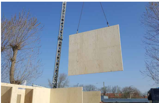
Stufenfalzplatte als Wandelement.
