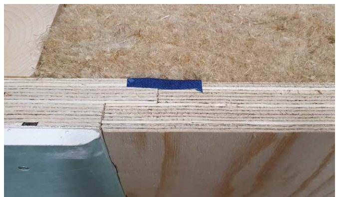
Abgeklebte Stufenfalzplatte mit Dämmung.
