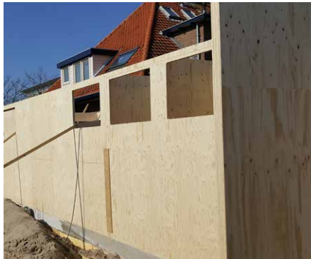
Kerto LVL Q-panel Stufenfalzplatten können sowohl für Bauteile von Einfamilienhäusern verwendet werden, als auch für Bauteile im Mehrgeschossigen Holzbau.
