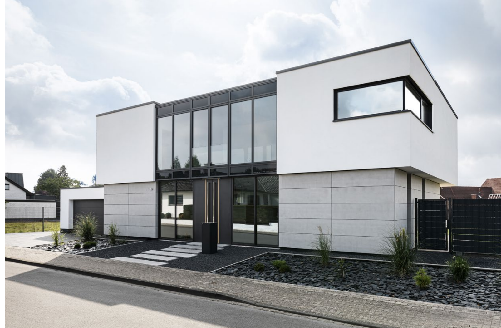
Fassadenbekleidung mit Dachüberstand und Carport (Bild unten). Die unsichtbare Befestigung und die durchgängige Linienführung, verleiht dem Objekt eine besondere Eleganz.
