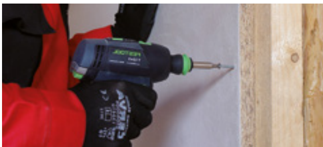
Bild Nr. 7: Befestigung mithilfe von Holzschrauben.
