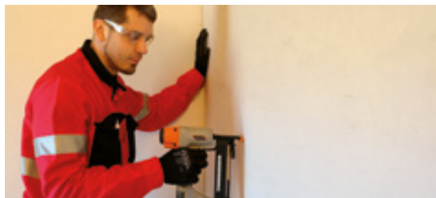
Bild Nr. 6: Verklammern von Platten.
